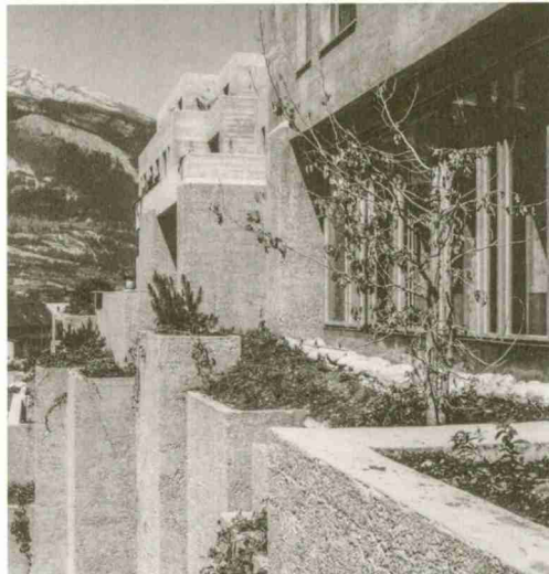
Pflanztröge als Teil der Architektur.
